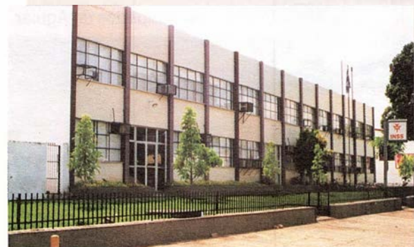
Prédio do Instituto Nacional de Seguridade Social, situado na Av. João Luís Ferreira, próximo à Beira Rio.
