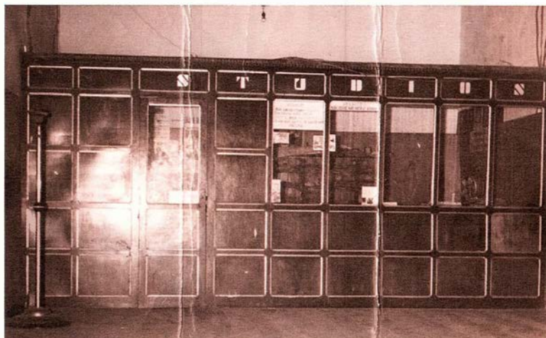
Vista geral dos estúdios da Amplificadora Florianense, no hall de entrada do Cine Natal - Década de 60.
