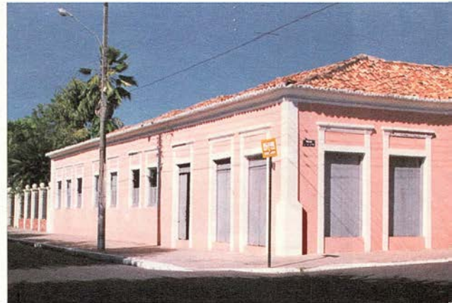
Prédio do Escritório das Fazendas Reunidas Raimundo Mamede de Castro. Era também a antiga residência do proprietário da referida empresa. Conservada a arquitetura original pelo seu sobrinho e sucessor Filadelfo Castro.
