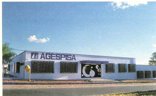
Companhia de Águas e Esgotos - AGESPISA - Av. Dirceu Arcoverde (Anel Viário)
