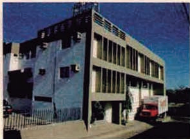
Sede Administrativa do Laboratório Sobral (Edifício Dr. Paulo Kalume), em Florianópolis, Piauí
